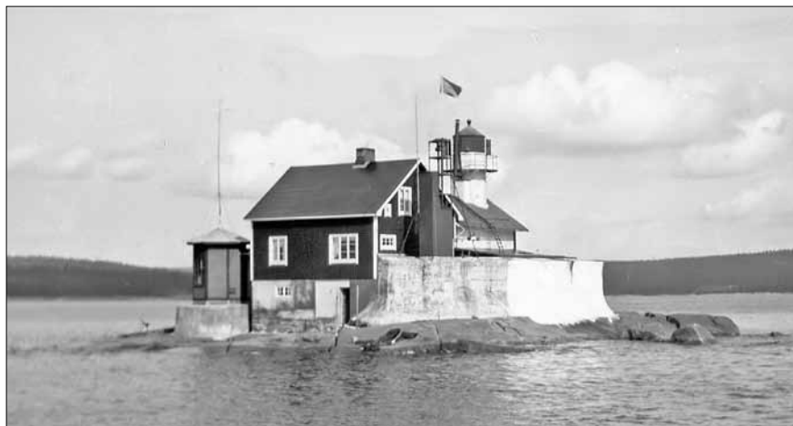
Fyrens utseende år 1927 efter den tillbyggnad som gjordes 1925.
