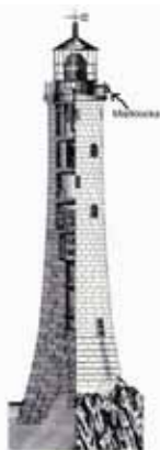
Den första fyren som byggdes färdig på Bishop Rock. Granitblocken som fyren byggdes av vägde 2500 ton.
