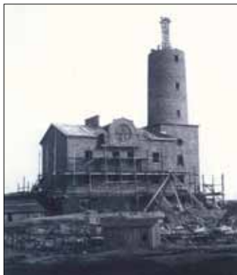
Bengtskärs fyr under byggnad 1906.
