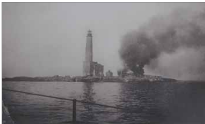
Beskjutning av fyren av egna batterier på Öro under slaget om Bengtskär 1941.
