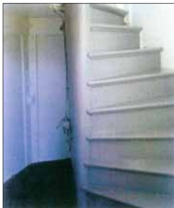
Fyren renoverades även interiört. Trappan är i original från 1904.
