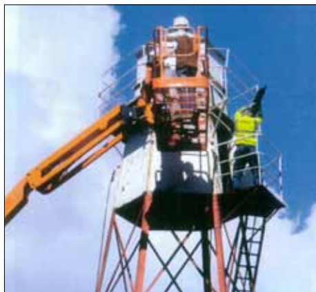
Gångbrädorna runt fyrhuset demonteras.
