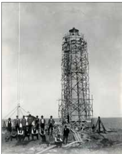
Det färdigputsade fyrtornet med en grupp söndagsfirande arbetare.
