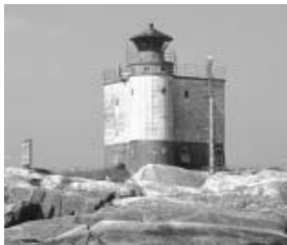
Tjärvens fyrplats 1999. Byggnadens stenväggar har klätts in med ljusa eternitplattor som ger ett bra skydd mot vådrets makter men tyvärr förtar byggnadens medeltida borgkaraktär.
