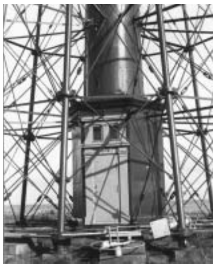
Närbild av Kapelluddens fyr, uppsatt 1872, med Gellerstedts prydliga entrédörr inramad av pilastrar. Fyren var tillverkad av Helsingborgs mekaniska verkstad och var tillsammans med den fyra år äldre Pater Noster den dittills högsta Heidenstamsfyren (32 m)
