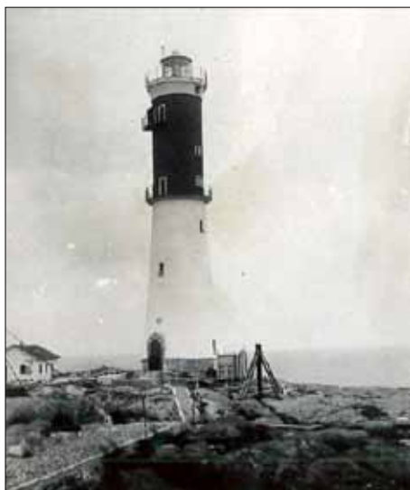
Understens nya fyrtorn helt färdigt 1916.
