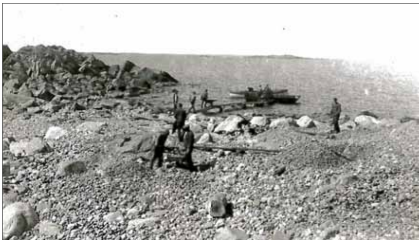
Lastning av singel. I bilden syns hopskottade högar. Förgrunden visar den varierande stenstorleken, som nödvändiggjorde sorteringen.
