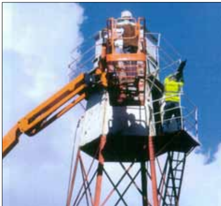
Gångbrädorna runt fyrhuset demonteras.
