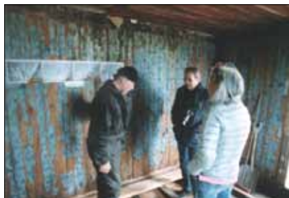
Christer Hollinder, Peder Öberg och Ulla Hillberg inne i Ratan Södra. Även tapeterna skall återskapas.
