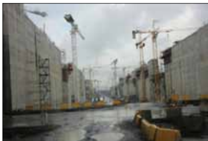
Slussarna i den nya "superkanalen" byggs för 400 m långa och över 50 m breda fartyg
