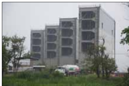
De nya slussstrappornas skjutportar är höga som tiövåningshus. Här uppställda på Atlantens strand i väntan på montering
