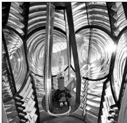
Fyrens linssystem. I centrum satt en glödlampa på 1000 W. Vid sidan av denna satt en reservglödlampa som ureds i arbetsläge när den första lampan var utbrunnen. Samtidigt gick signal till vakthavande fyrvaktare.
