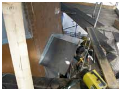
Nyttilverkat tak över entrén.
