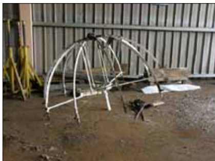
Delar av den nedmonterade lanterninen..
