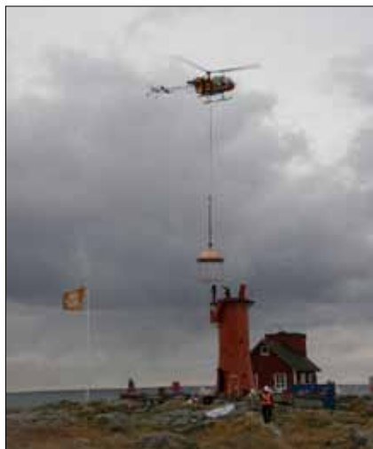
Lanterninen flygs ut för att placeras på Tylöns totalrenoverade fyr.
