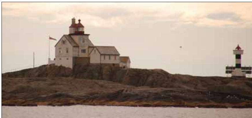
Finnværets gamla fyr är ersatt av en modern solcellsdriven.
