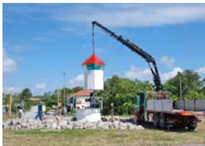
Kråksundsgapsfyren monteras i rondellen.
