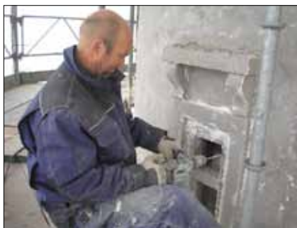
Betongglasen i det södra fyrtornet har bytts ut.
