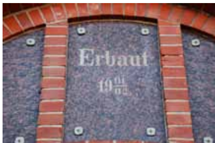
Portaldetalj, nya fyren.
