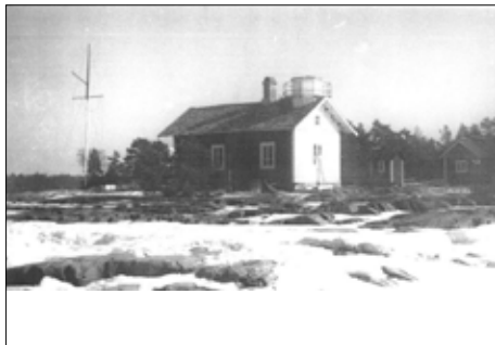
Fyrstugan utan lantermin men med signalmast.
