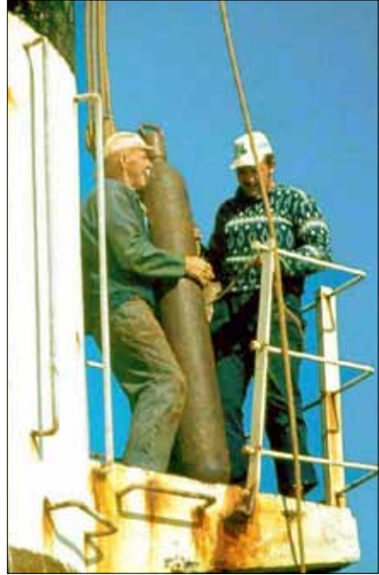
De tunga tuberna förs ut till fyrbalkongen för att krokas i och firas ner.
