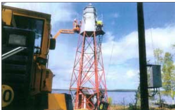
Den skrapade och grundmålade fyren täcks nu med ett första lager vit färg som skall följas av ytterligare två lager. Fotogenhuset har också setts över.
