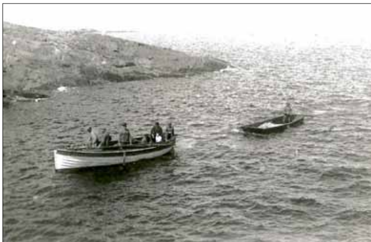
Fyrbåten med lanschan lastad med singel på väg in i Norrskrubbän. I båten en del av lossarlaget.
