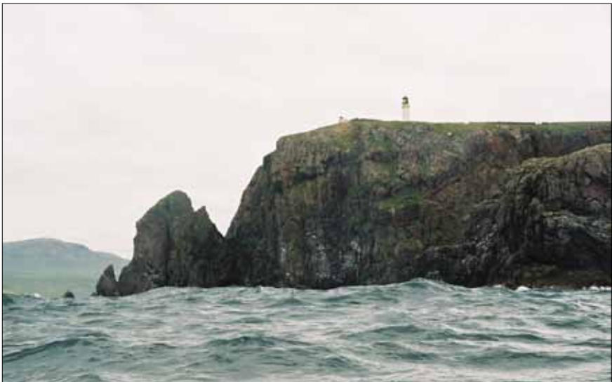
Varningen från Mr John att inte gå för nära kanten var befogad!
