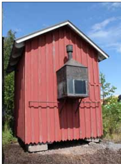
Vålarö fyr, numera placerad vid lotsstationen i Öxelösund. Fyren var ursprungligen vitmålad.
