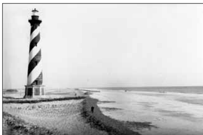
Ursprungligt läge på, då fyren byggdes, betydande avstånd från stranden.
