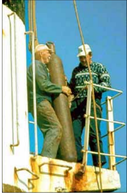
De tunga tuberna förs ut till fyrbalkongen för att krokas i och firas ner.
